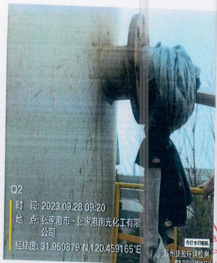
采样点位: DA002 废液废气焚烧炉废气排放口 Q2
